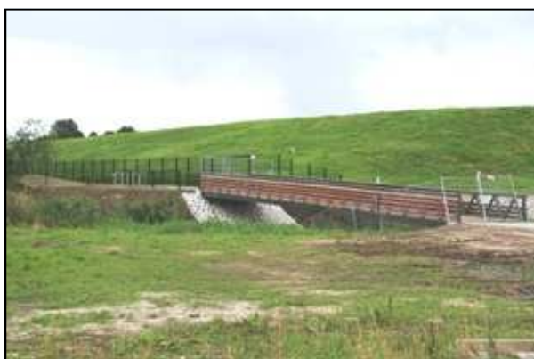
Wijkspeelplaats Meerendonk in aanleg.
